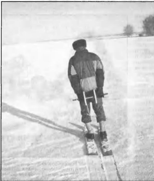
Растянуть двухкилометровый тонкий провод — антенну Beverage — по снежной целине непросто. Виктор на широких охотничьих лыжах Владимира совершил эту «прогулку», разматывая по пути катушку с проводом.
