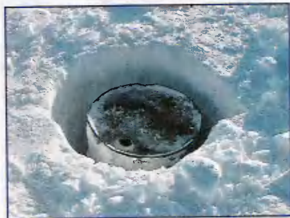
Бочки для крепления мачтовых оттяжек антенн Yagi.
