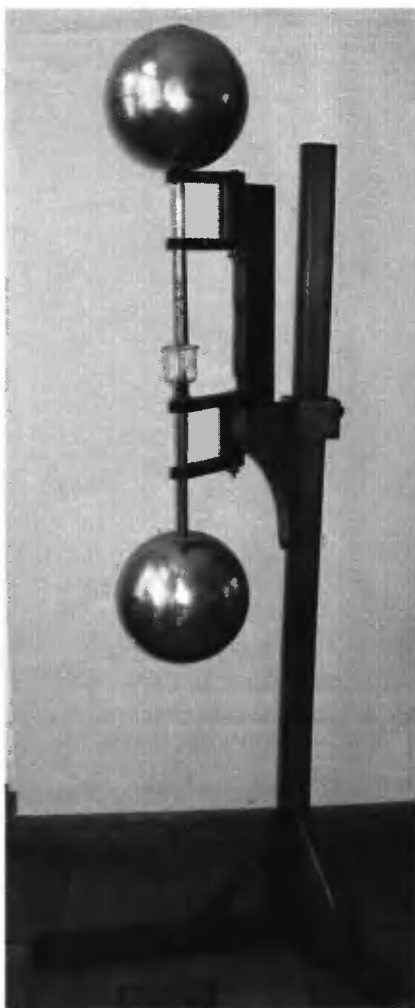
Разрядник передатчика судовой радиостанции.
