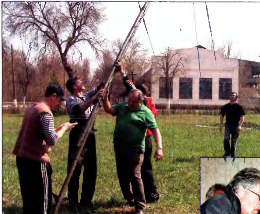
Установка антенны радиостанции EM20U.
